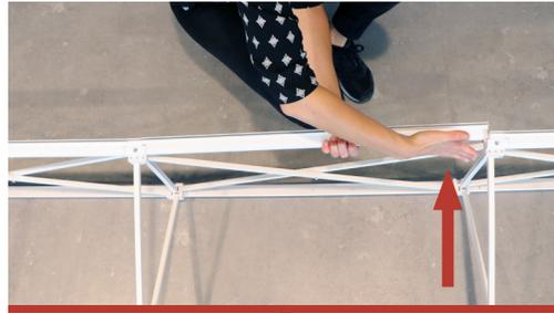
1. Para sacar las barras, déles un golpe firme hacia afuera en ambos extremos.
